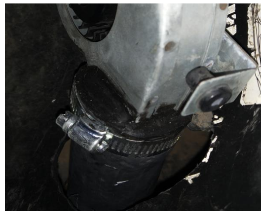
Gambar 8 Sambungan Yang Sudah Di Lem Menggunakan Silicon Sealant
