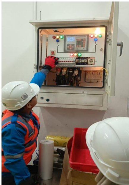
Gambar 4. Proses Perbaikan ATS
