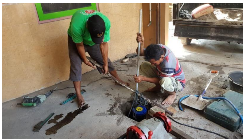
Gambar 6. Proses Pemasangan Hidrolis Tanam
