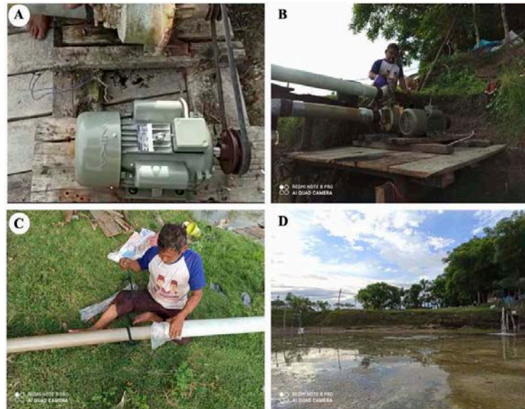
Gambar 4. Tahapan pengisian air di kolam tandon. Keterangan: (A) dan (B) pemasangan pompa air, (C) instalasi saluran air pada kolam tandon, (D) pengisian air di kolam tandon.
