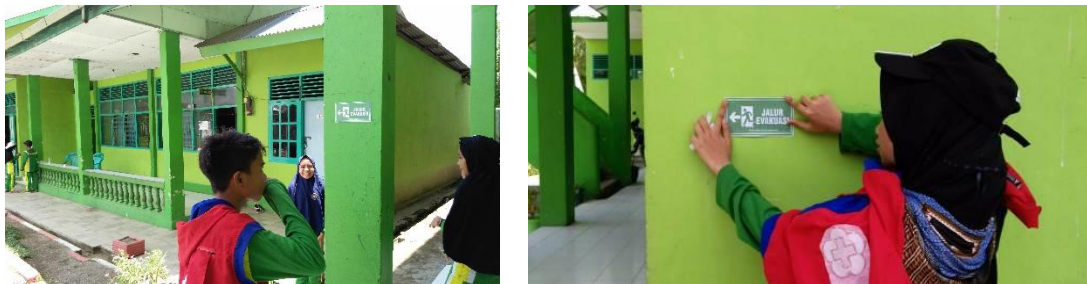
Gambar 5. Pemasangan atribut jalur evakuasi dan titik kumpul
