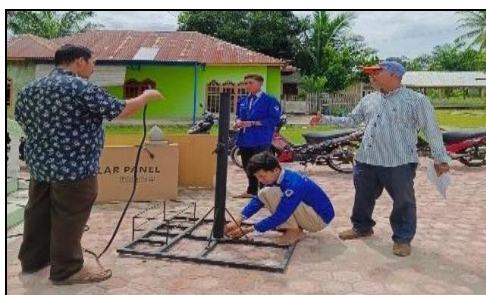
Gambar 3. Pemasangan Penyangga Portable PLTS Off-grid
