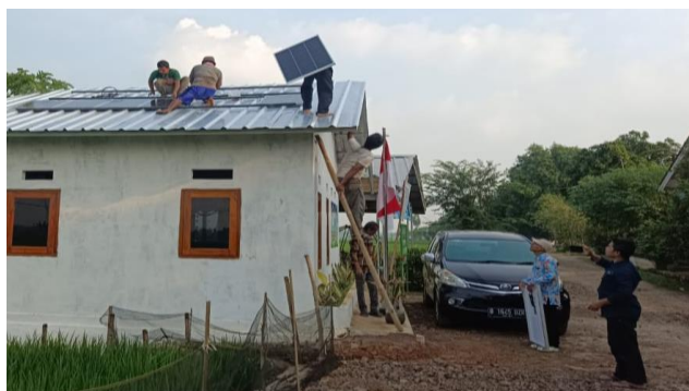
Gambar 4. Pemasangan Panel Surya
