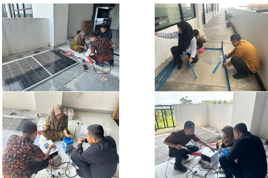
Gambar 6. Perakitan Solar Panel
