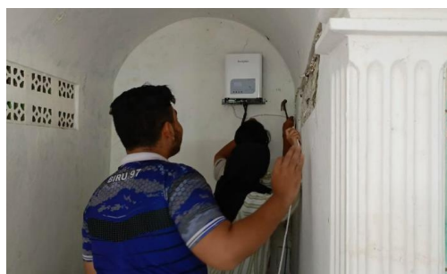
Gambar 8. (a) Pemasangan Inverter dan (b) Pemasangan Baterai
