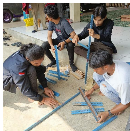
Gambar 7. Merakit Kerangka Dudukan Panel Surya akan Diletakkan di atap sekolah
