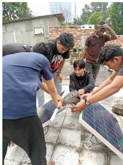
Gambar 6. Kegiatan Pemasangan Panel Surya di atap gedung sekolah
