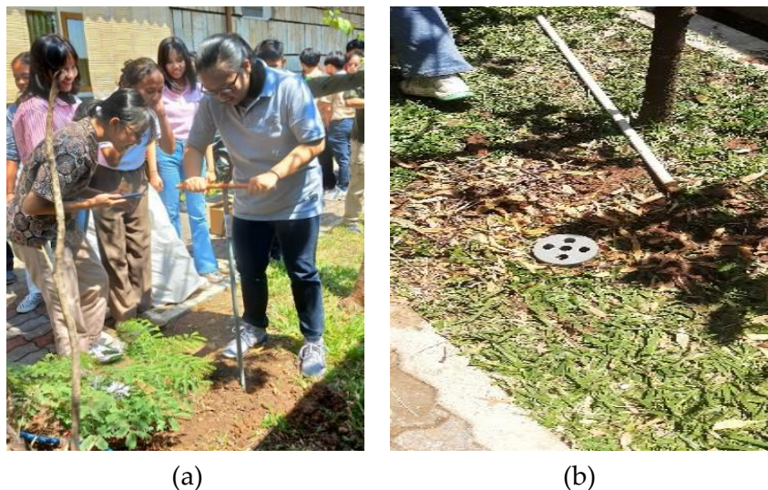
Gambar 8. Pembuatan biopori di SMA K Satya Wacana
