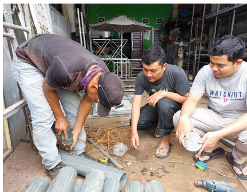
Gambar 3. Pemotongan Pipa PVC dan Pemberian Lubang pada Pipa PVC
