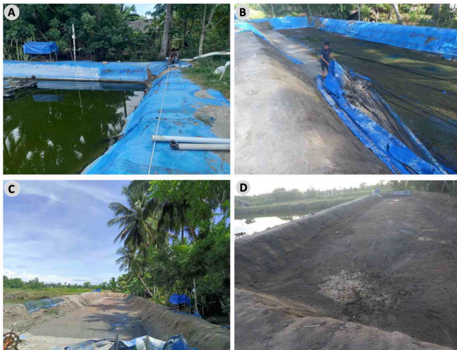
Gambar 2. Pengukuran luas lahan kolam (A), pembersihan tambak (B), rekonstruksi Tambak (C), hasil rekonstruksi Tambak (D)
