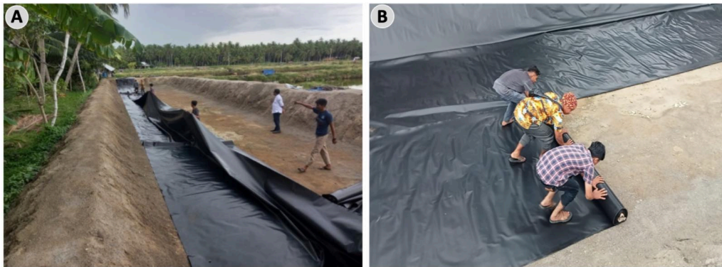
Gambar 3. Pembentangan terpal HDPE yang dilakukan pada kelompok Laut Mina Budidaya
