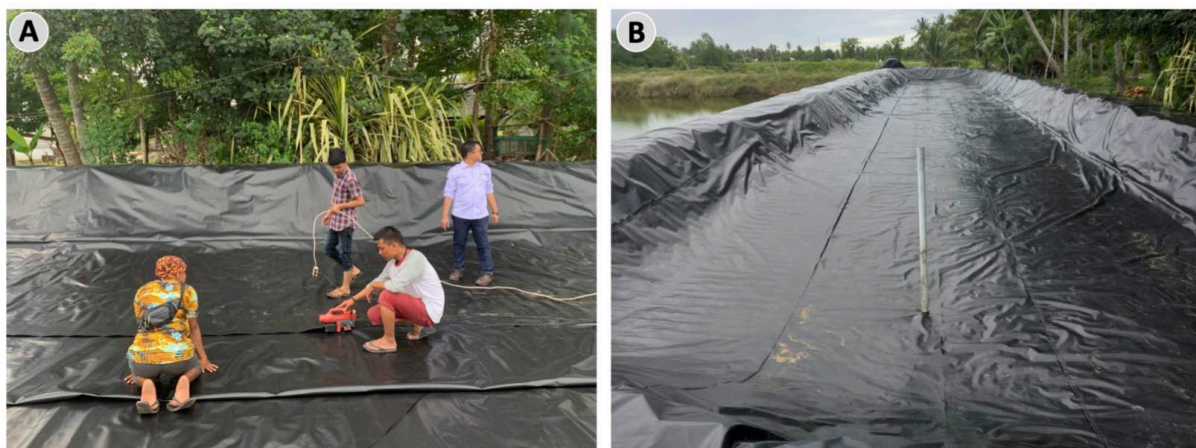
Gambar 4. Proses pengeleman sisi ujung ke ujung terpal HDPE (A) dan hasil pemasangan terpal HDPE (B)
